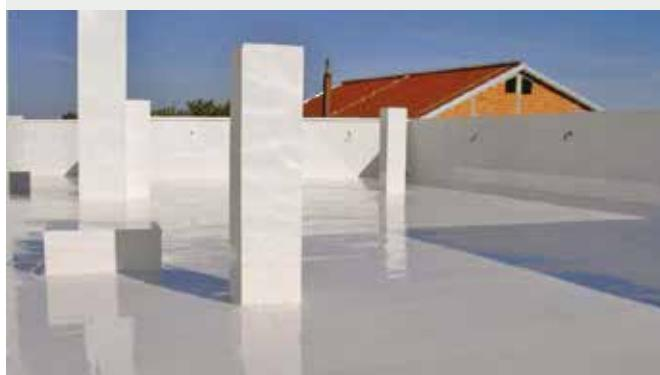
**CERMIPROOF PU** یک ماده تک جزئی ، با ویسکوزیته پایین از جنس پلی اورتان، مایع، ماده ایزولاسیون و محافظت کننده در برابر آب است. یک غشاء بسیار الاستیک در نتیجه عمل آمدن با رطوبت به وجود می آورد.
